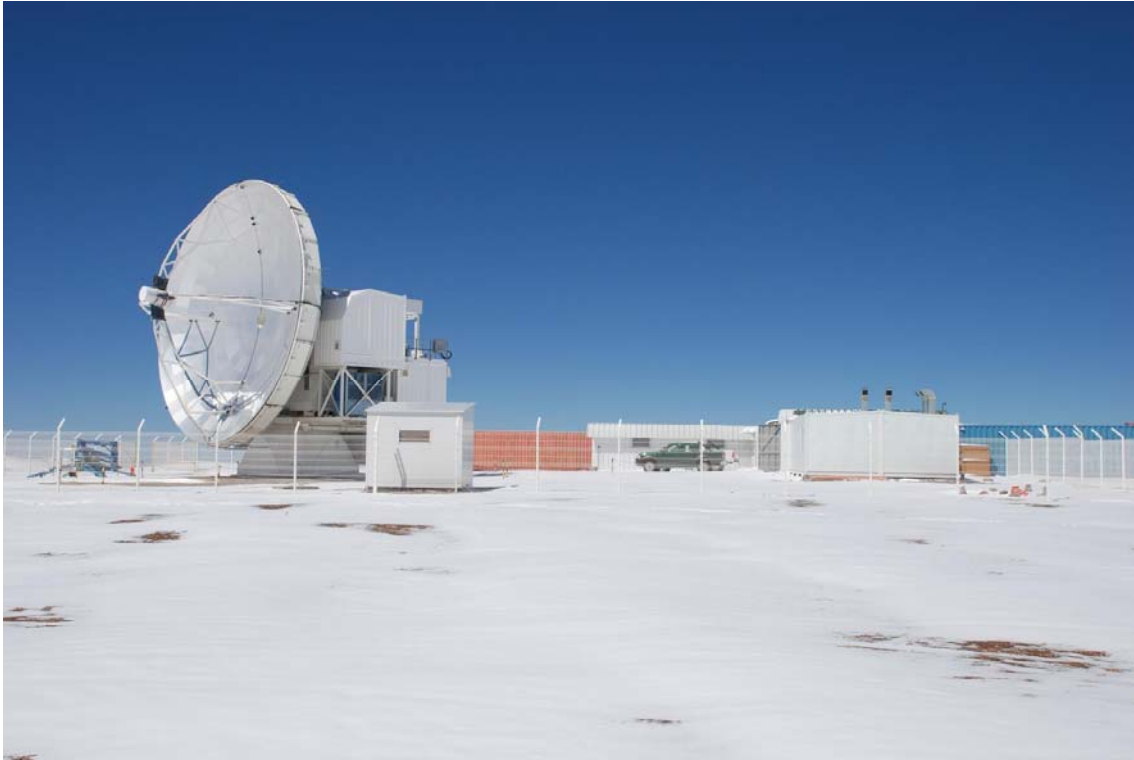
Figura 5: Antena perteneciente al Proyecto APEX, construida sobre la base de un prototipo realizado para el proyecto ALMA, actualmente en operaciones en Chajnantor, Chile. La misma es similar a la planeada para el proyecto LLAMA
