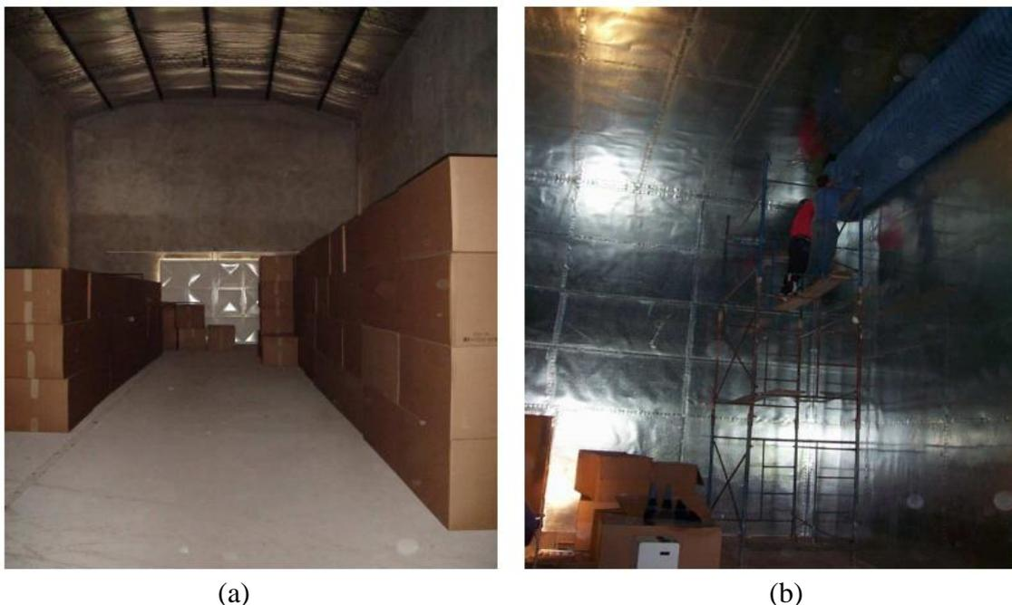
Figura 18. Cámara anecoica IAR. (a) Recinto utilizando para la construcción de la cámara. (b) Láminas de hierro galvanizado revisten las paredes.
