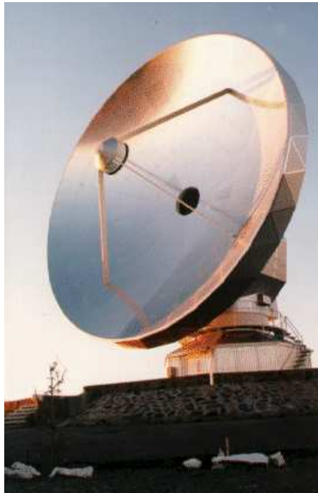
Figura 6.2: Antena de 15 m del radiotelescopio Swedish-ESO Submillimetre Telescope (SEST), ubicado en La Silla, Chile (hasta hace poco tiempo).
